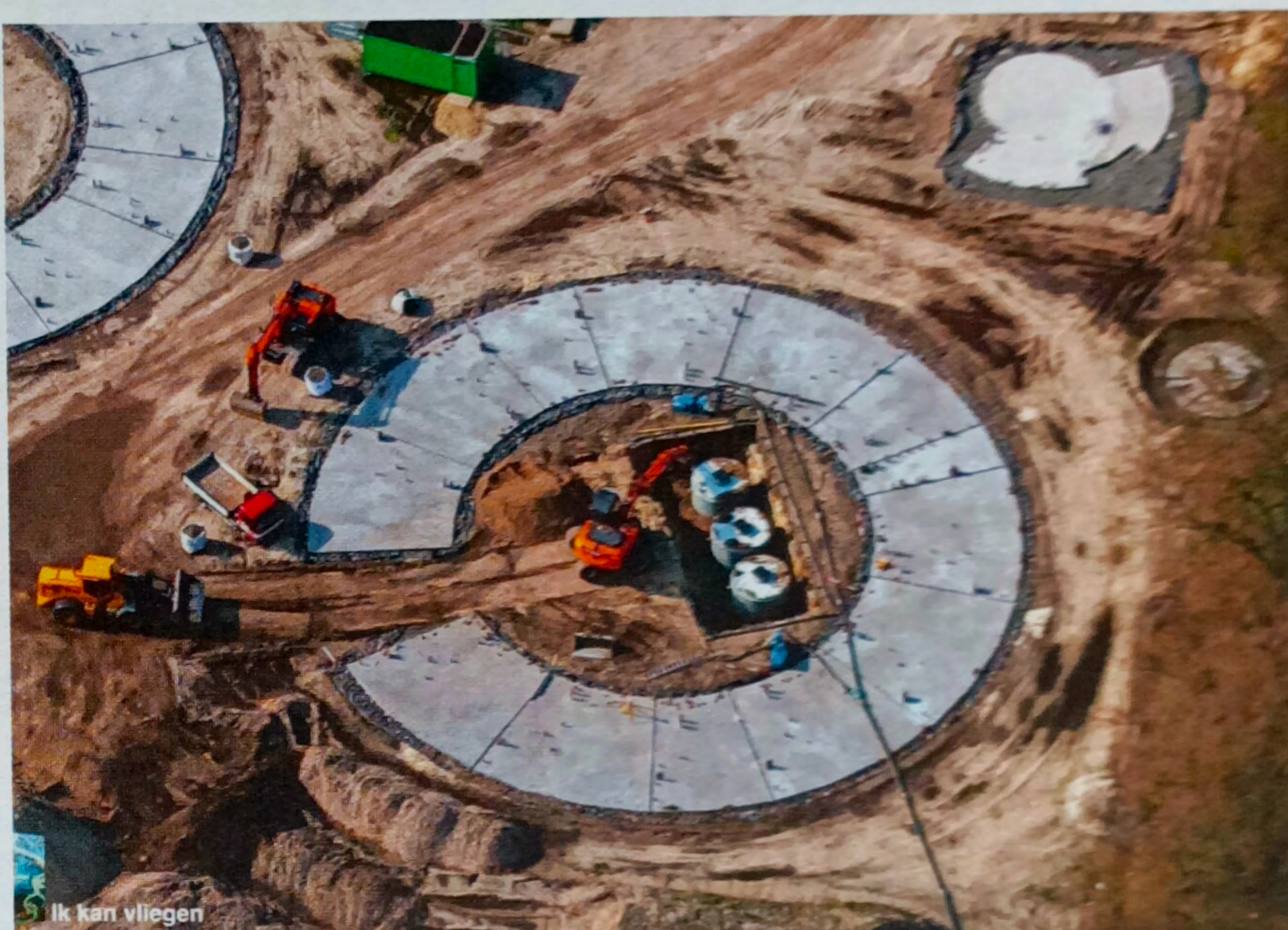
Begane grondvloer met in het hart de ondergrondse tanks voor regenwateropslag.
