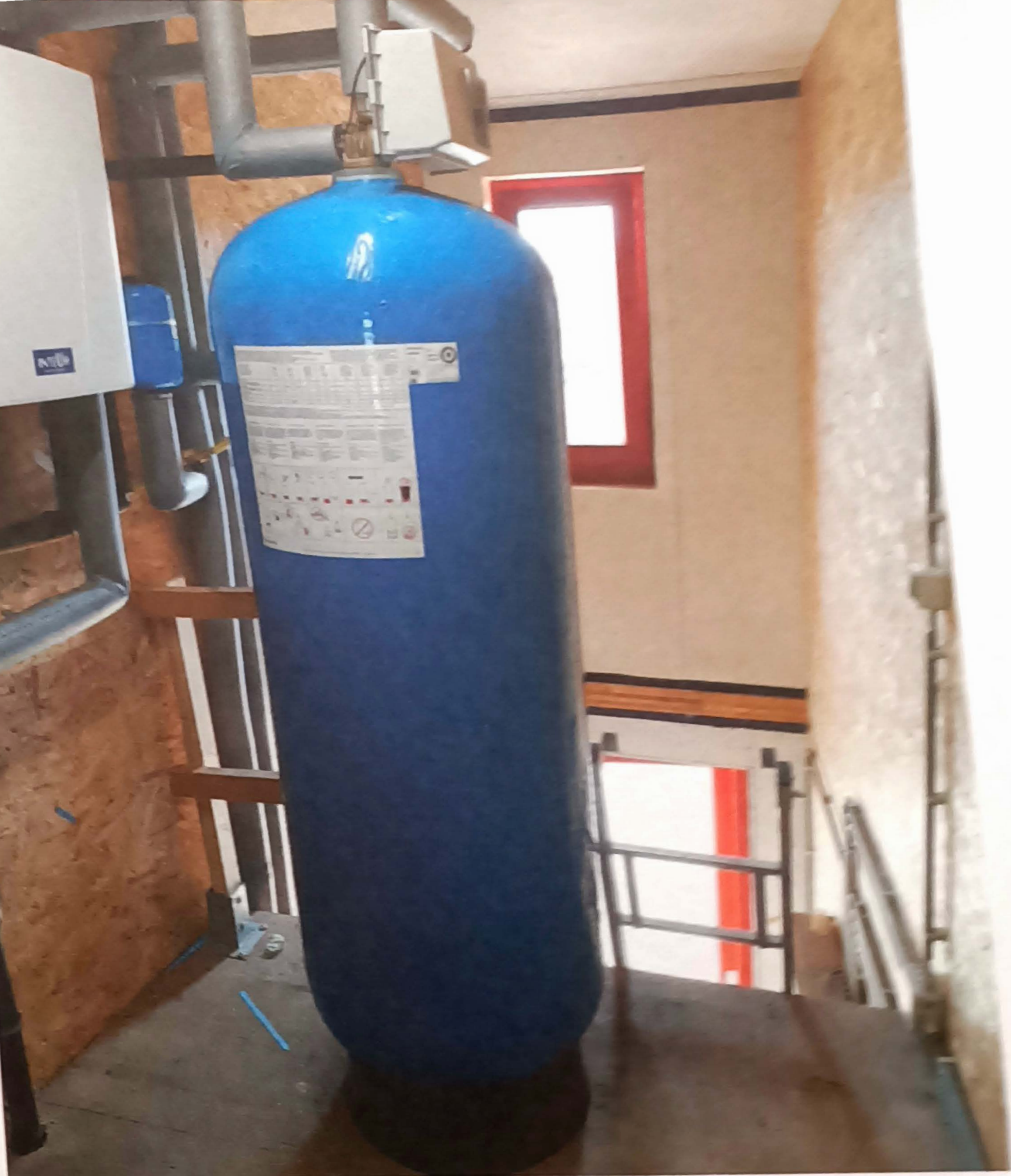
Het pompsysteem (links) en het actieve koolfilter voor de ontkleuring van het regenwater.
