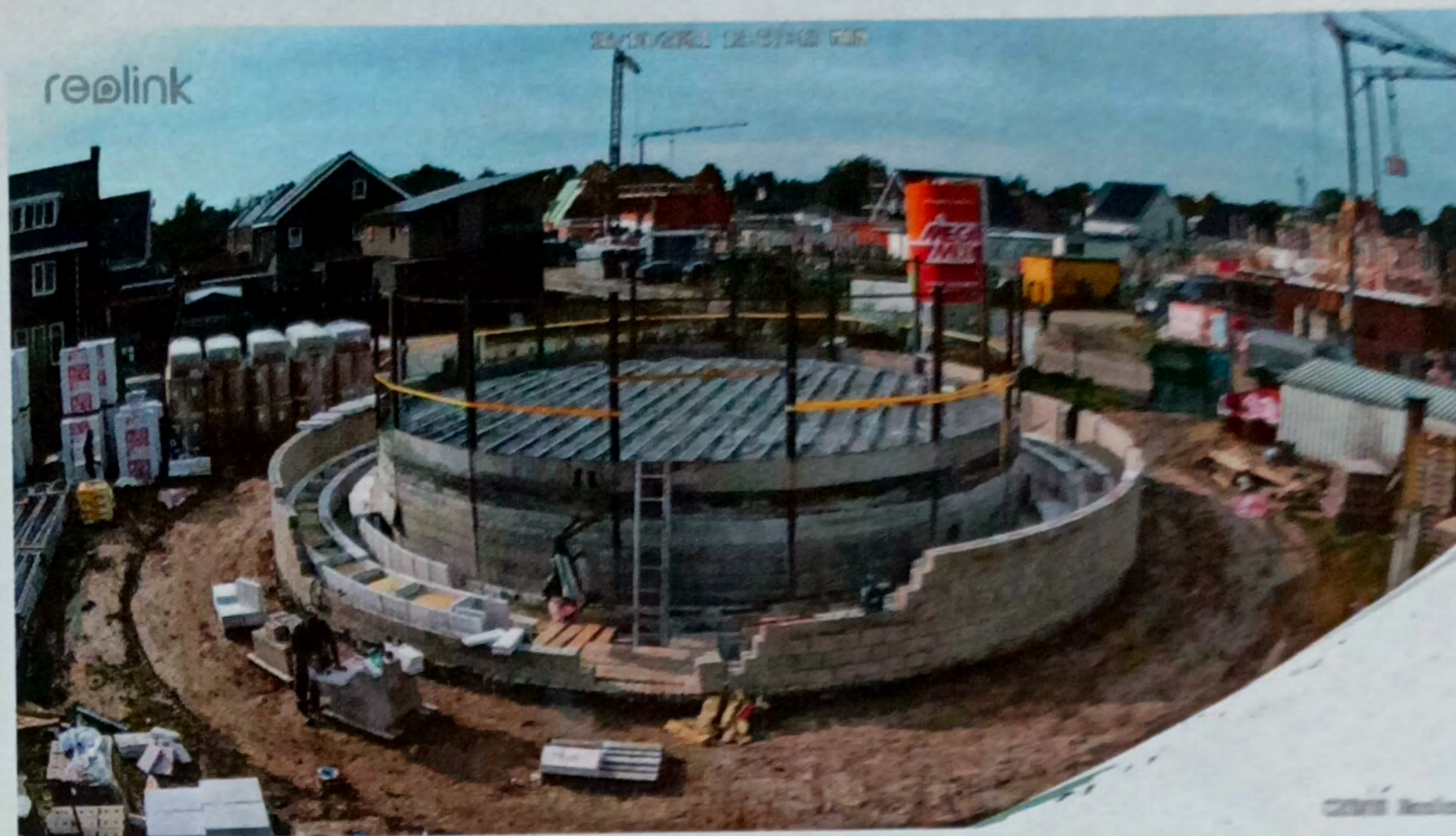
De warmteaccu in aanbouw. Komende winter kan het systeem in werking worden gesteld.
