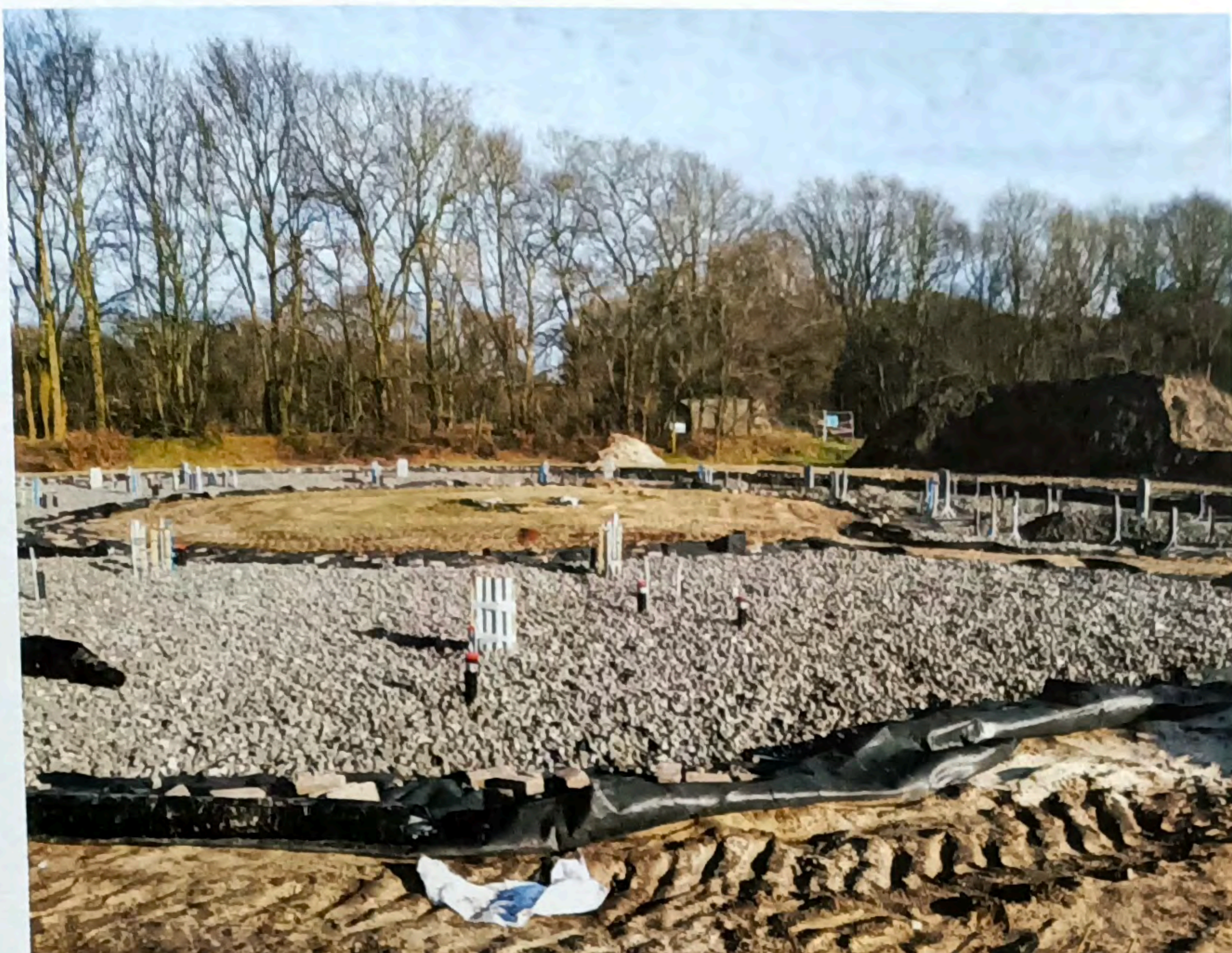
Glasschuim met ondergrondse infrastructuur.
