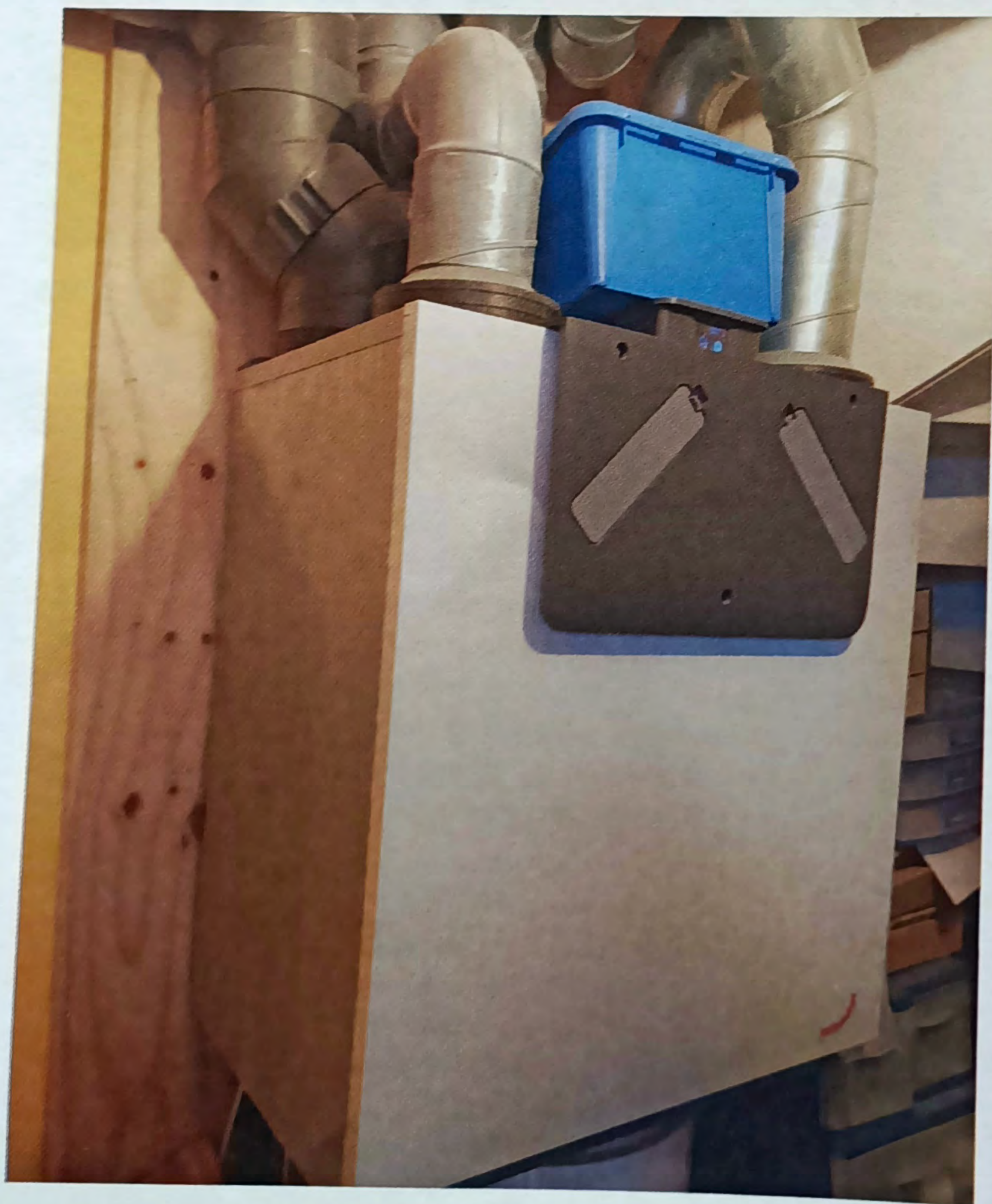
De woningen zijn luchtdicht gebouwd en worden geventileerd met balansventilatie met warmteterugwinning.
